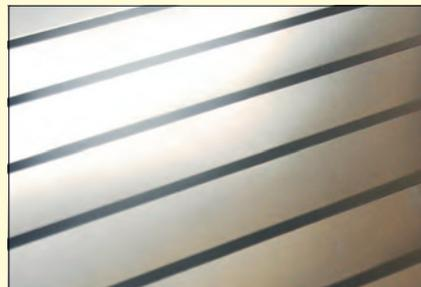
Falls mal eine oder mehrere Lamellen ausgetauscht werden müssen - z.B. bei Beschädigung - lassen sich diese vom Ab-deckungskörper lösen, ohne die ganze Abdeckung demon-tieren zu müssen. Erreicht wird dies durch eine Steckver-bindung von Korpus und Schutzlamelle. Beschädigte Lamellen können so schnell und kostengünstig vom Arbeits-raum aus ausgewechselt werden.
